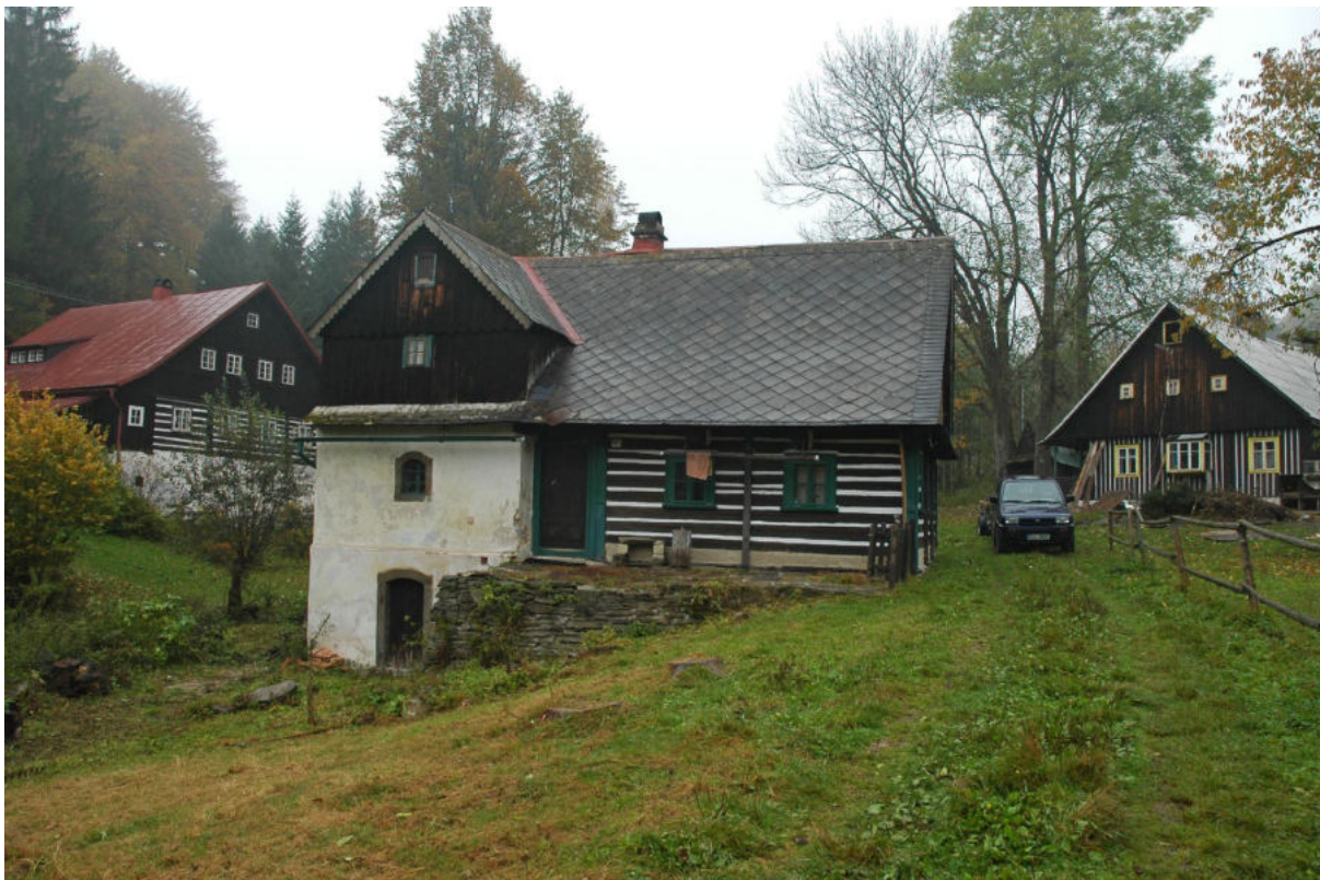
20. Údolní zástavba s domy č.e. 56, 62 a 55 (foto J. Pešta)
