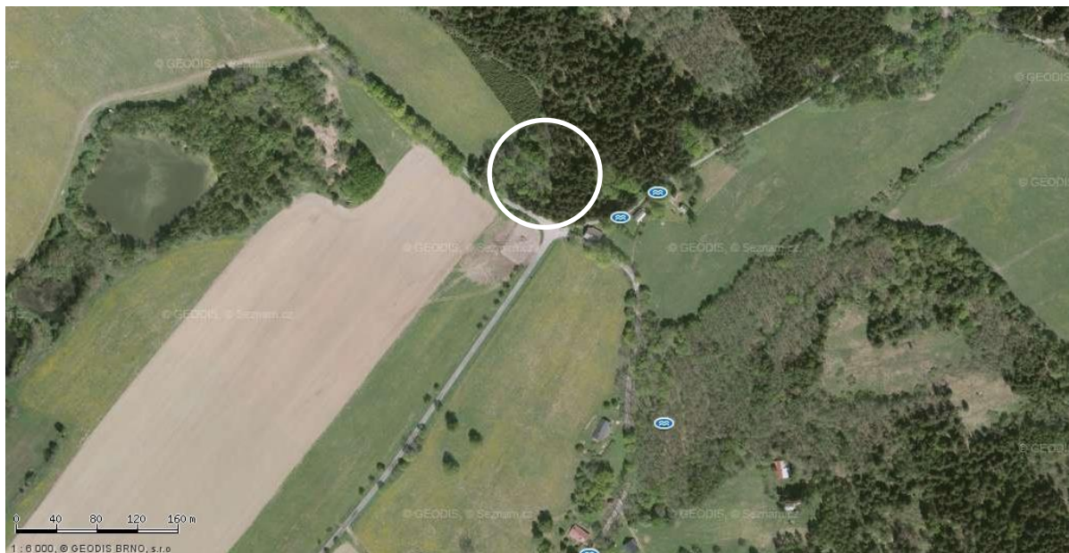
Letecký pohled na současný stav (vlevo kačerovské rybníky, vpravo kačerovské rašeliněště)
