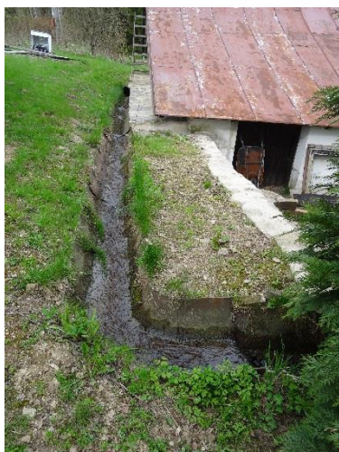
Obr. 9, 10 Ocelové koryto a vyústění potoka u ev.č. 040
