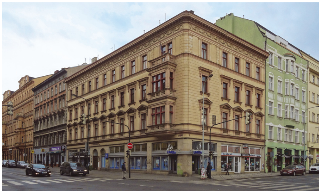
Dům čp. 560 na rohu Žitné ulice a Karlova náměstí v Praze
